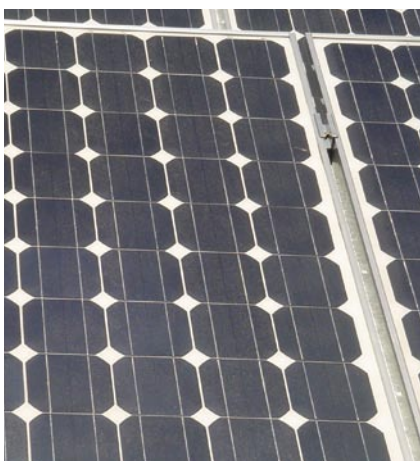
Módulo solar fotovoltaico de célula de silicio monocristalino
