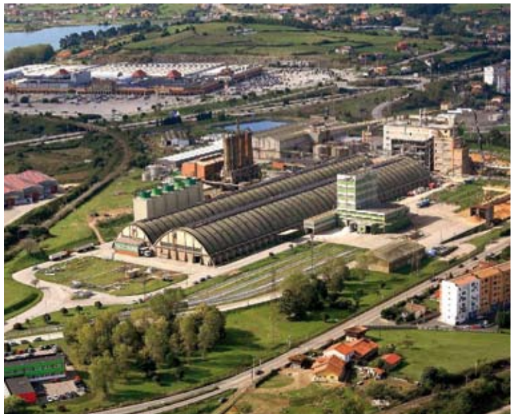
Vista general de la Fábrica de Asturias en Trasona (Corvera de Asturias)
