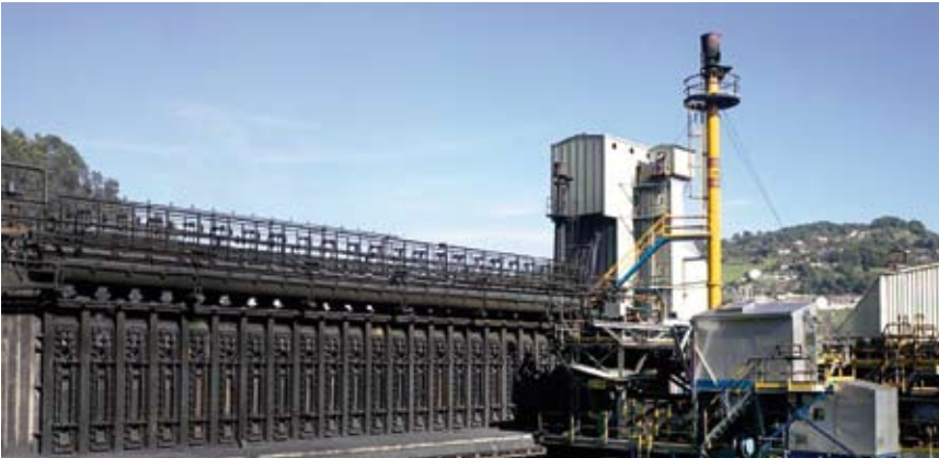
Instalaciones de coque en el centro de La Nueva (Langreo)
