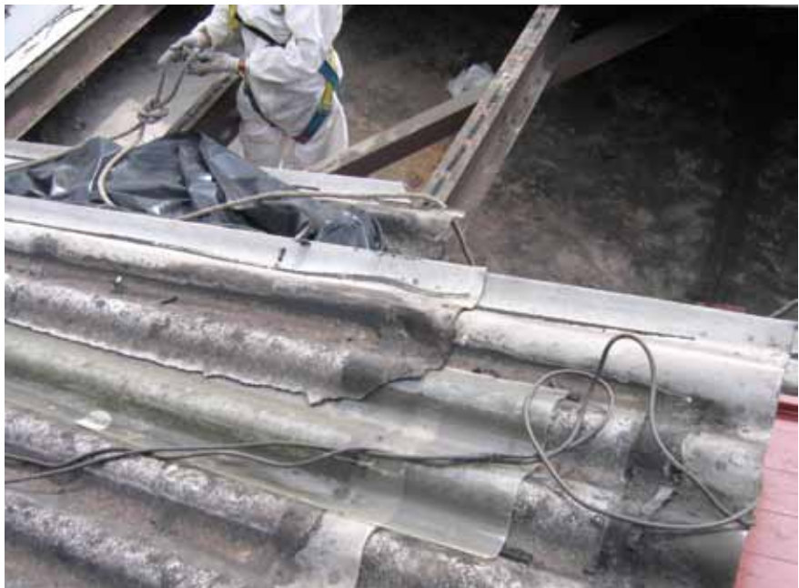
Retirada de una cubierta con amianto
