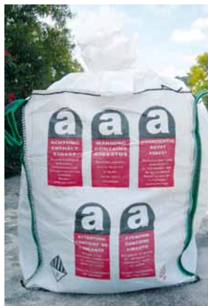
Residuos de amianto embalados para su transporte a vertedero autorizado
