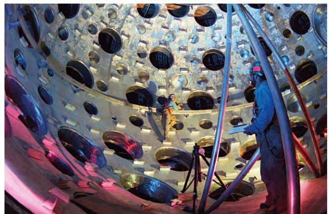
*Esta fotografía muestra cómo fue la construcción de la cámara esférica del experimento NIF. En los orificios de sus paredes se instalaron posteriormente los láseres responsables de la condensación del combustible alojado en la microbola*
